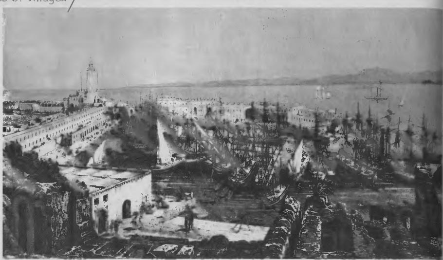
Le môle et le port d'Alger.
