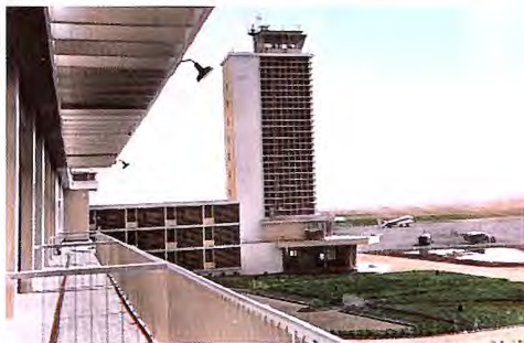
Aéroport d'Alger-Maison Blanche
