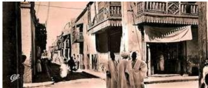
Les balcons de la rue Arcelin
