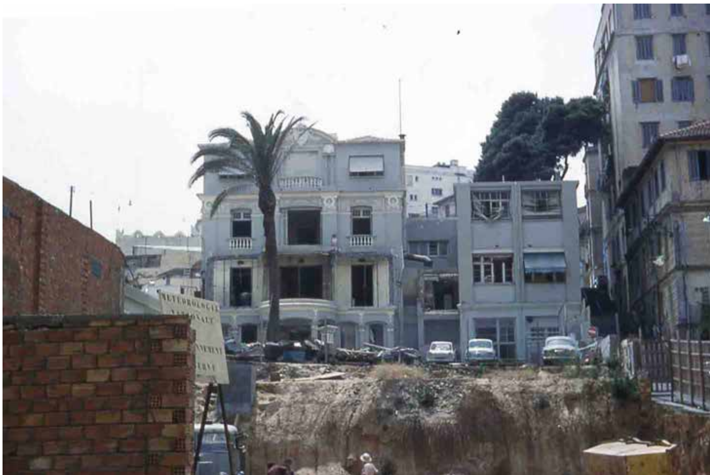
▲ Le bâtiment de la Météorologie Nationale, villa Grima, rue Bastide à Alger, après le plastiquage de juin 1962
