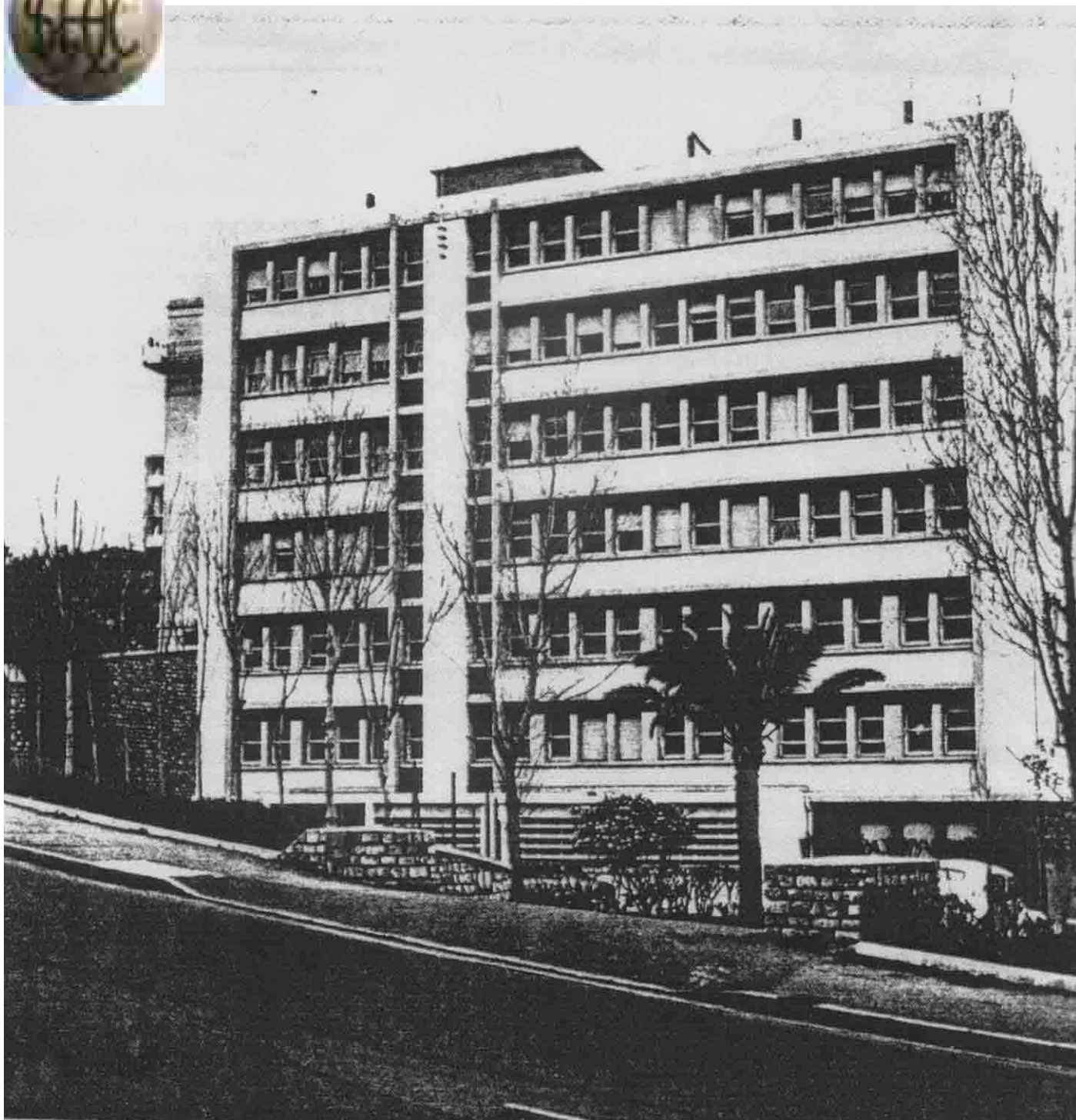
▲ Le bâtiment de la Direction de l'Aviation Civile en Algérie, boulevard Savorgnan de Brazza à Alger, en 1960
