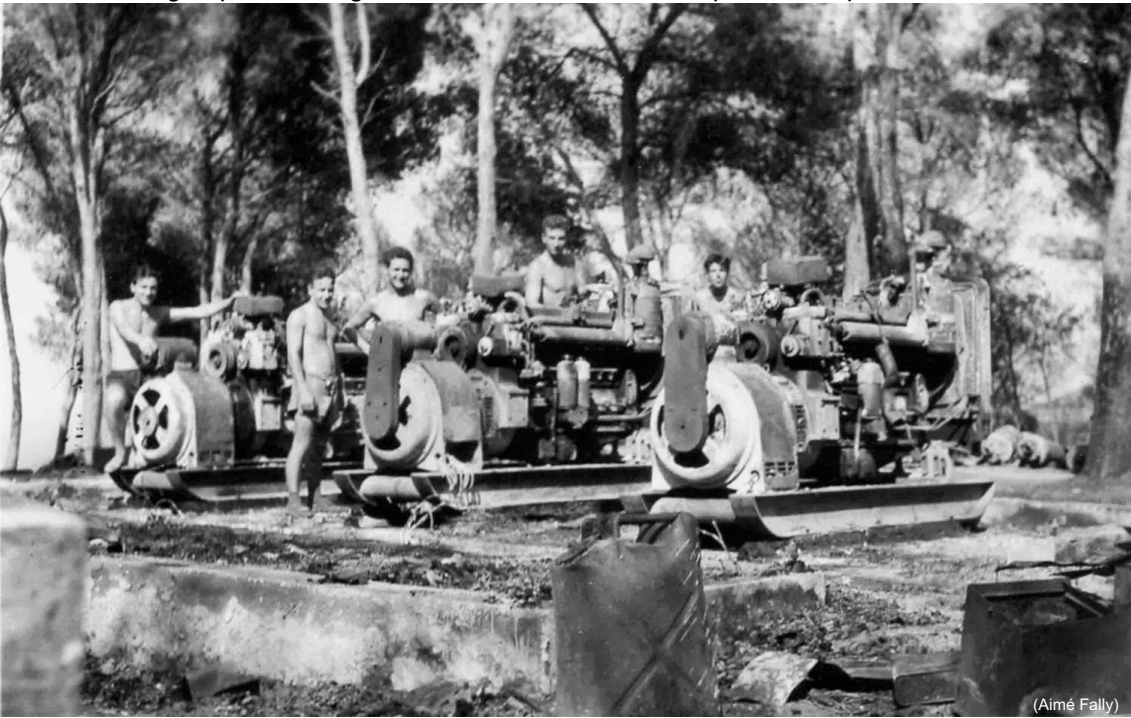
Les groupes électrogènes de la station radar du cap Caxine, après l'incendie
