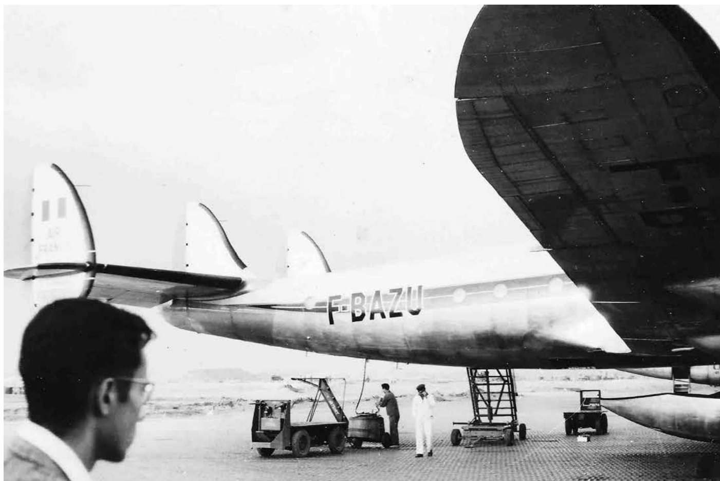
▲ Maison-Blanche le 20 juillet 1954, Jean-Pierre Chillo et le Constellation F-BAZU. Vidange des toilettes et, sous l'avion, le speedpak, conteneur amovible pour le transport des bagages
