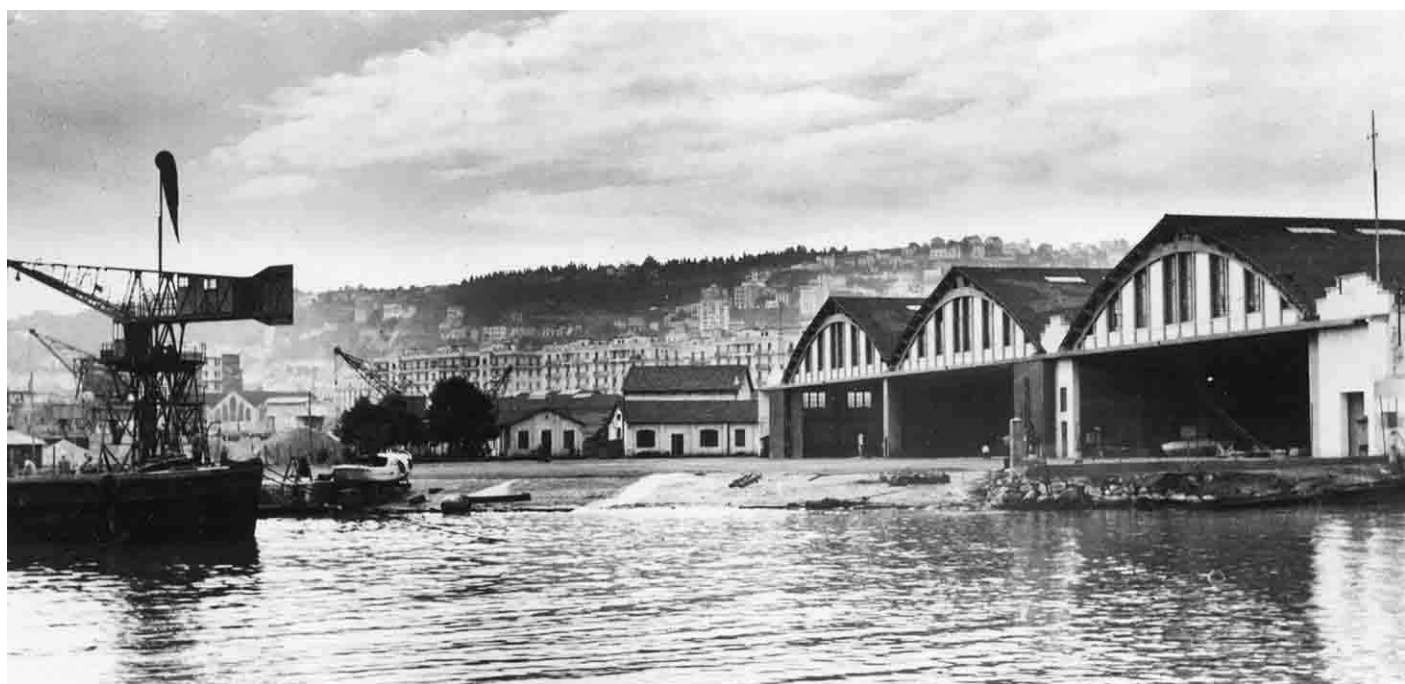
L'hydrobase d'Alger-Agha construite par l'Aéronautique Navale en 1917, à gauche, la grue Derrick de manutention des hydravions
