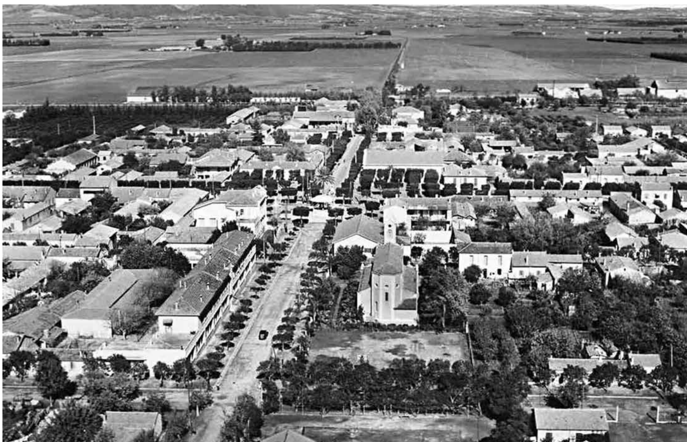
▼ Mouzaiaville, en haut : La Grande Ferme et l'aérodrome
